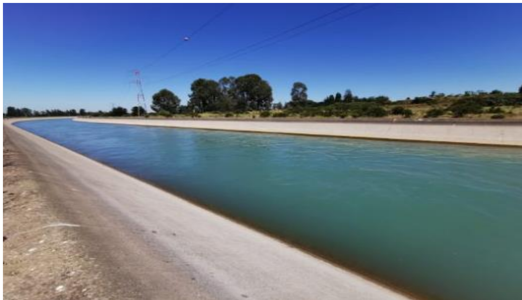
Figura 31. Canal de Devolución Machicura. Fuente: Hidroeléctrica Colbun.
